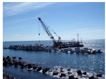
海岸保全工事
