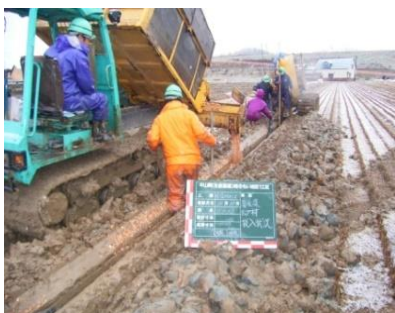
暗渠排水工事
