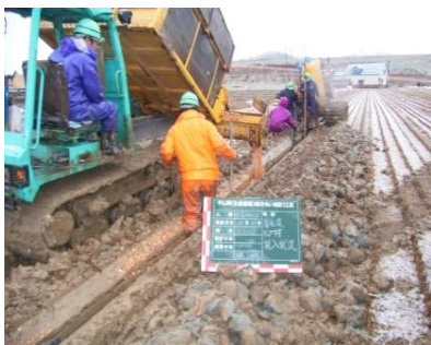
暗渠排水工事
