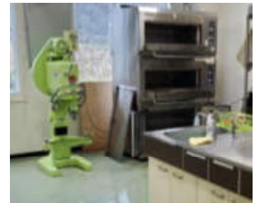
写真14 留萌管内農産加工室機材設置状況確認 (パンミキサー、オーブン)
