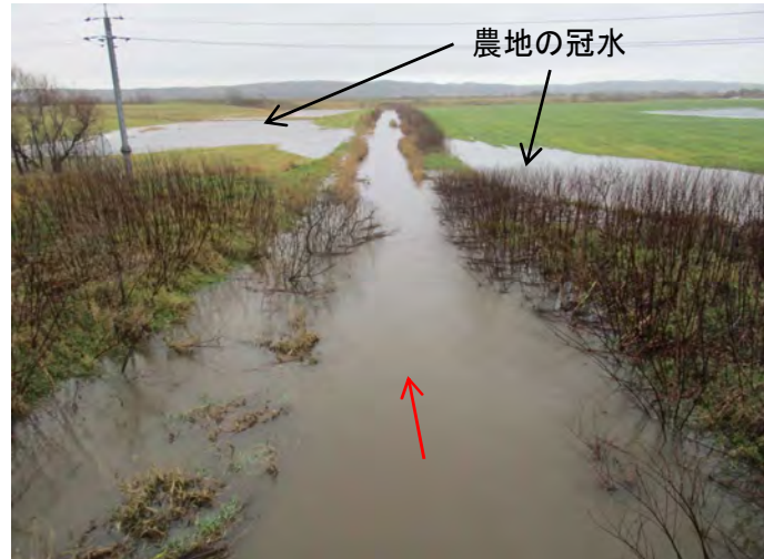
令和2年11月の協進橋下流の浸水被害
