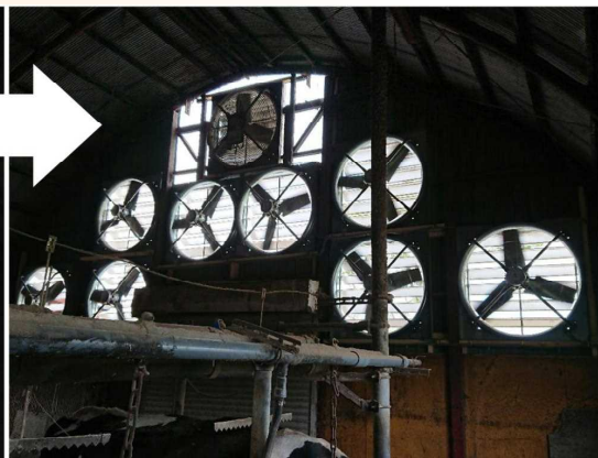
改善後 (換気扇の増台)
