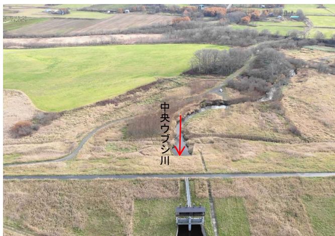
優先整備区間（作返1号樋門上流）
