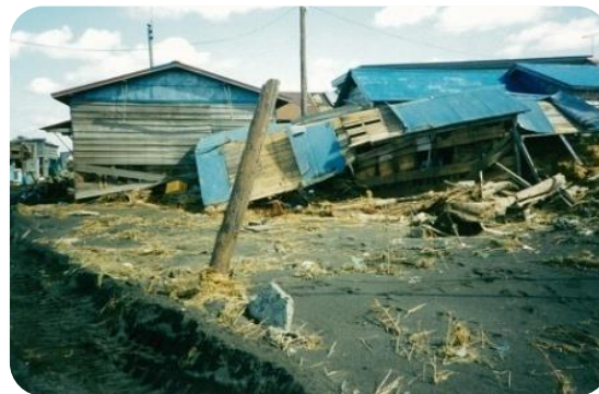
平成16年 台風18号による被害状況
