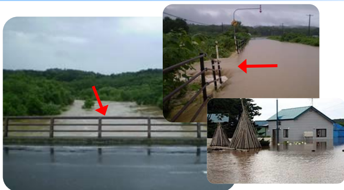
平成22年8月豪雨による浸水状況
