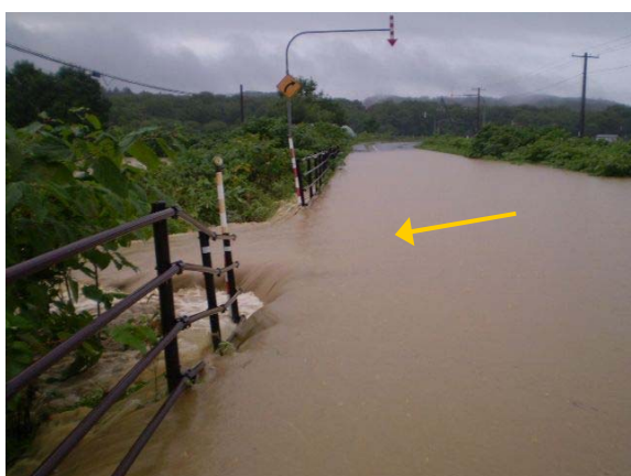
写真-5 清川地区浸水状況(平成 22 年 8 月)
