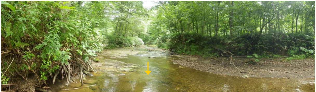
写真-7 上流域河道状況(道道遠別中川線より上流)
