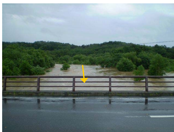
写真-6 清川地区出水状況(平成 22 年 8 月)
