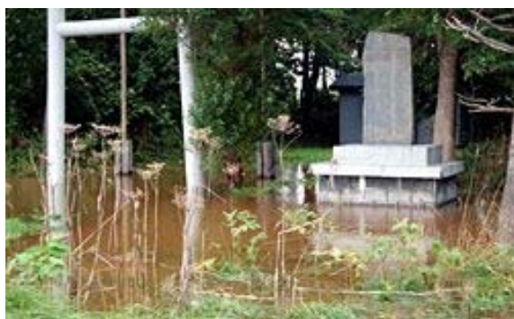
写真-3 啓明地区浸水状況(平成 22 年 8 月)
