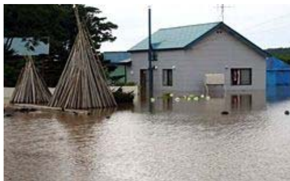
写真-4 啓明地区浸水状況(平成 22 年 8 月)
