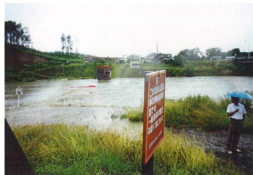
昭和56年8月台風15号 三毛別川： 天竜橋より上流洪水氾濫状況
