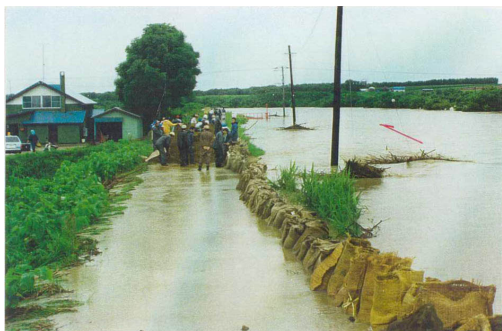
昭和56年8月台風12号 古丹別川： 金刃比羅橋より下流洪水氾濫状況
