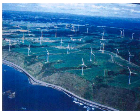
写真1 風力発電施設
