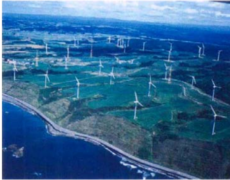
写真1 風力発電施設
