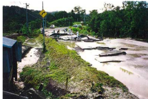
平成6年8月豪雨 三毛別川： 松下橋より上流洪水氾濫状況
