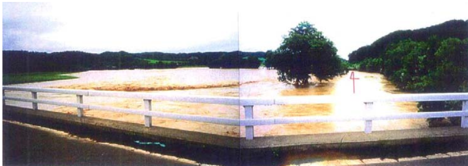
平成11年7月豪雨 古丹別川：岩見橋より下流洪水氾濫状況
