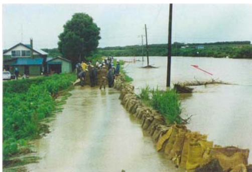
昭和56年8月台風12号 古丹別川： 金刃比羅橋より下流洪水氾濫状況
