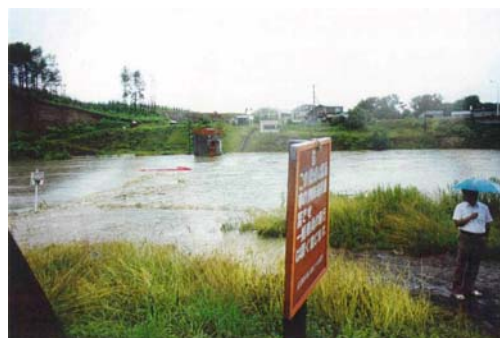
昭和56年8月台風15号 三毛別川： 天竜橋より上流洪水氾濫状況
