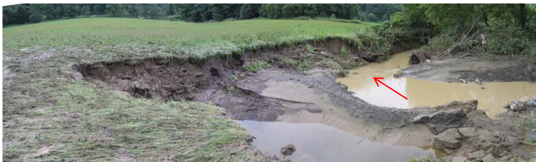
平成 22 年 8 月の二十三号川桔杭橋 きっこう 下流の浸水被害
