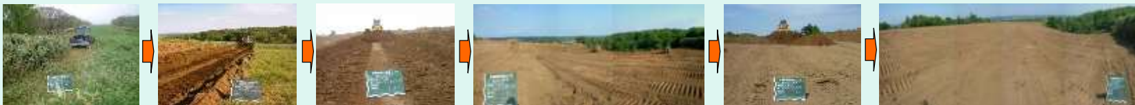
【着手前ほ場】 【表土剥ぎ】 ブルドーザ 【基盤切盛】 ブルドーザ 【基盤切盛完了状況】 【表土戻し】 ブルドーザ 【表土戻し完了状況】
