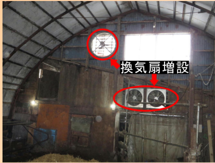
写真4 換気扇増設 (陰圧排気側より撮影)
