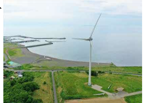
苦前夕陽ヶ丘風力発電所(苦前町)
