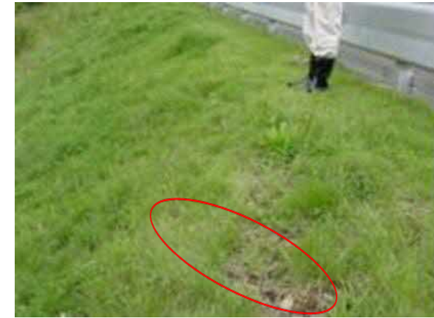
【堤体法面に「陥没」や「亀裂」、「はらみ出し」が生じている箇所がある】
