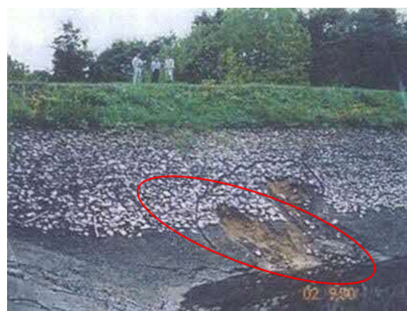
【堤体法面に「陥没」や「亀裂」、「はらみ出し」が生じている箇所がある】
