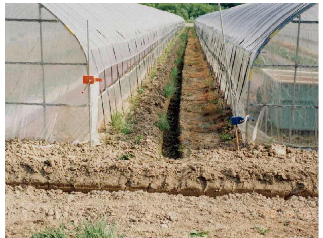
写真1 簡易排水路の設置例
