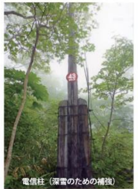
電信柱(深雪のための補強)
