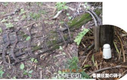
朽ちた電信柱 雪害柱製の罫子
