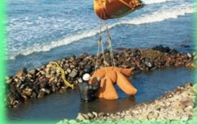
鉄鋼スラグ・腐植土設置
