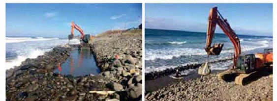
図：施工の様子（2014年10月）
