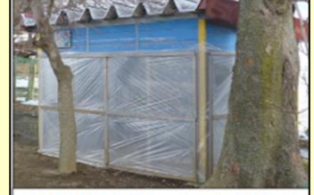
寒冷対策を兼ね、シートを張った野生動物の侵入防止対策
