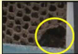
金網等の破損修繕
