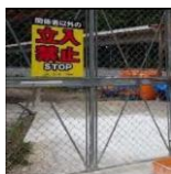
侵入防止フェンスの設置
