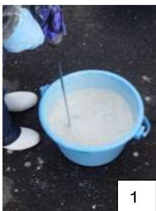
水と塗布用消石灰を混ぜる
