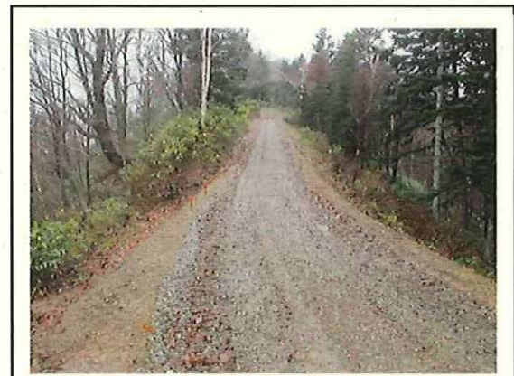
既設林道の補修
