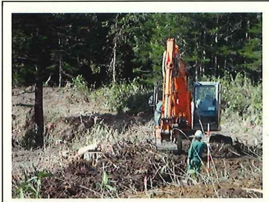
大型機械による地拵え
