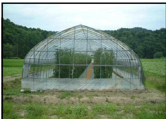
図 背面の換気事例
