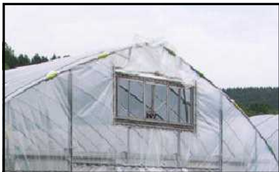
図 妻窓による換気事例
