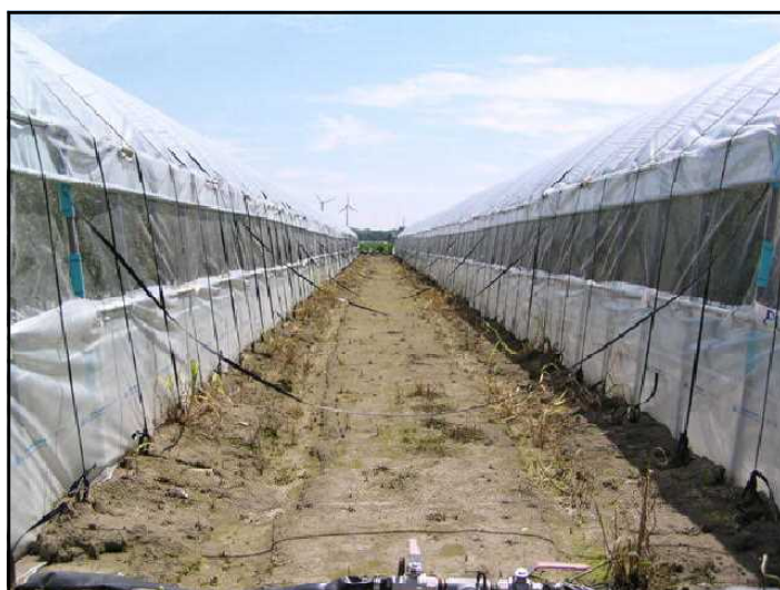
図 バンドによる側面換気の事例
