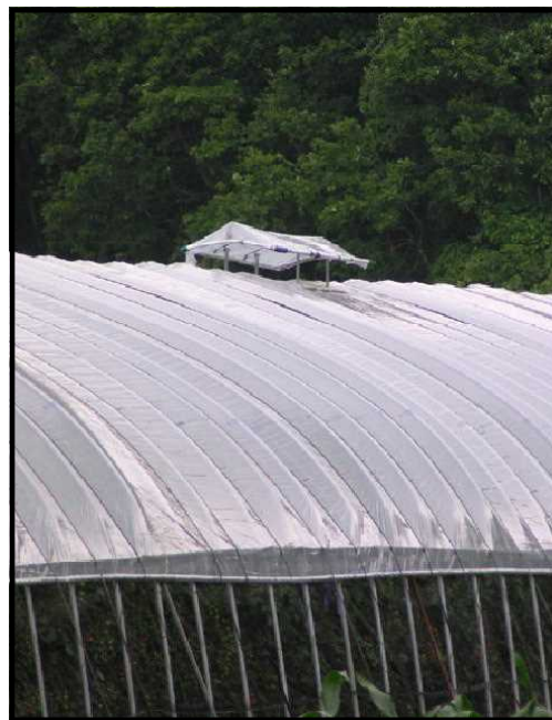
図 天窗による換気事例
