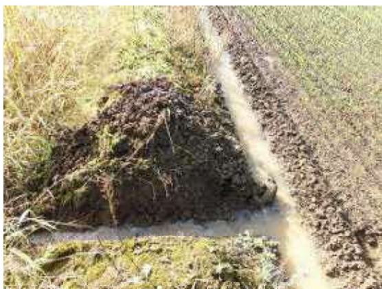
写真1-25 額縁明渠と畦切りによる排水促進
