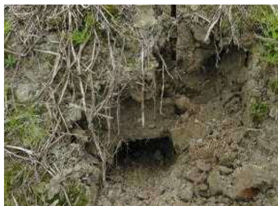
写真1-23 カットドレーン施工穴
