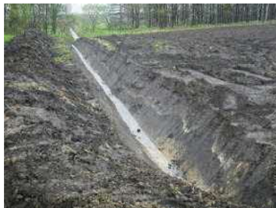
写真1-21 明渠の施工(自力施工)
