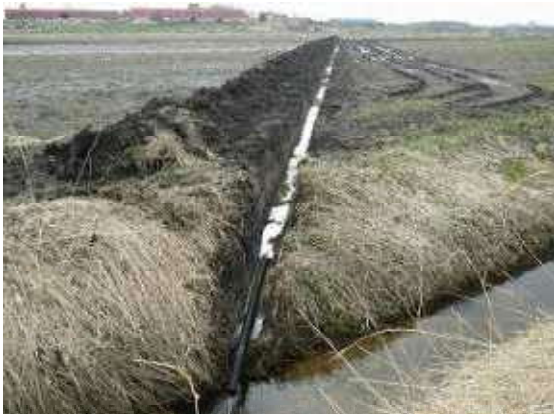
写真1-20 暗渠の施工(基盤整備事業)
