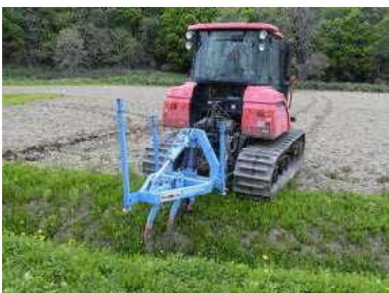
写真1-24 明渠からの施工(排水先へつなげる)
