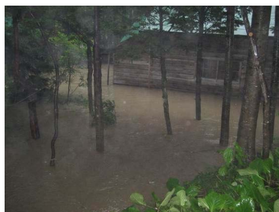
写真-4 浸水状況(平成22年7月) 大川橋右岸下流
