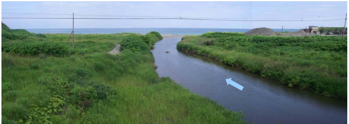
写真-8 下流域 河道状況
