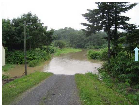
写真-5 浸水状況(平成22年7月) 大川橋左岸下流
