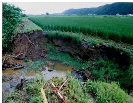
写真-3 平成11年の河岸決壊状況
