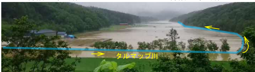
写真-6 樽真布橋下流の浸水状況 (平成30年7月)
