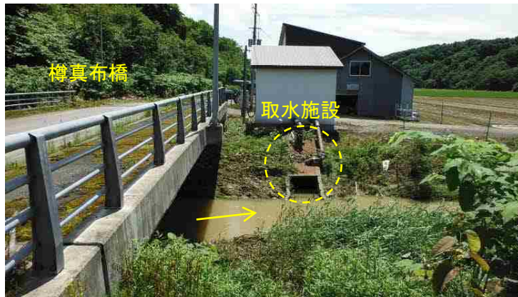
写真-8 樽真布橋下流左岸にある取水施設
