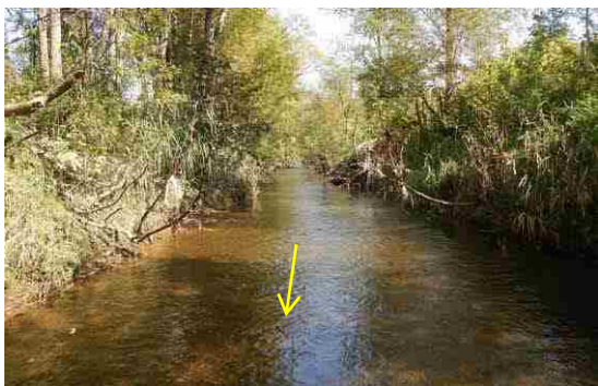
写真-9 留萌川合流部から上流方向の河道内
