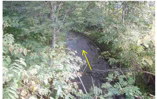
写真-16 齊木橋から下流方向の河道内
