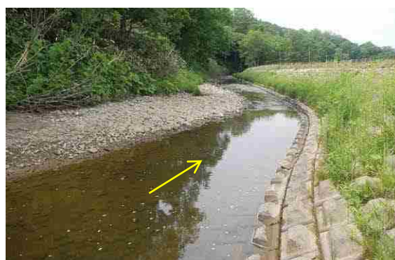
写真-12 田村川合流部から下流方向の河道内
