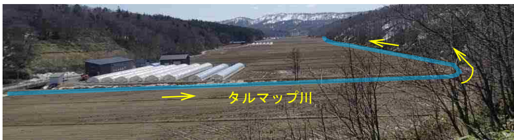
写真-7 樽真布橋下流の現況 (令和2年4月)
